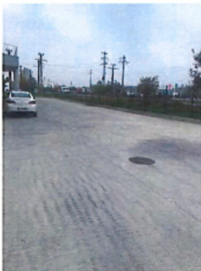
Constructii speciale: platforma betonata si imprejmuiri
