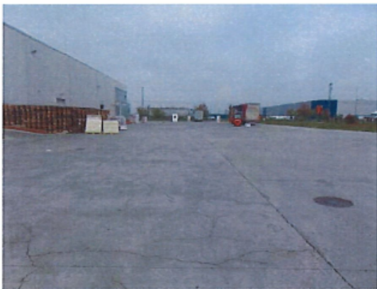
Constructii speciale: platforma betonata si imprejmuiri
