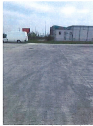
Constructii speciale: platforma betonata si imprejmuiri
