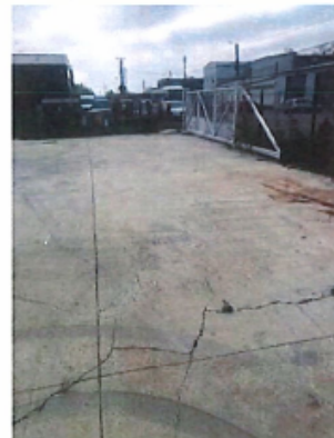
Constructii speciale: platforma betonata si imprejmuiri
