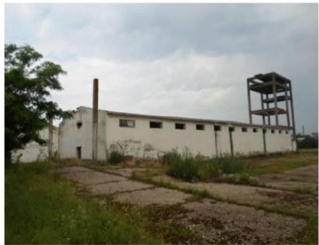
Constructia cu regim de inaltime Parter, are suprafata construita de 217 mp, fundatie din beton, suprastructura din zidarie portanta de caramida, acoperis cu sarpanta chesoane beton cu invelitoare din placi de azbociment.
