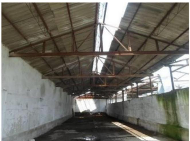
Constructia cu regim de inaltime de parter, are suprafata construita de cca. 320 mp, fundatie din beton, suprastructura din zidarie portanta de caramida, sarpanta metalica cu invelitoare din azbociment.
