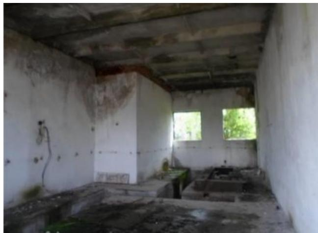
Constructia cu regim de inaltime de parter, are suprafata construita de cca. 155 mp, pe fundatie din beton, suprastructura din zidarie portanta de caramida, acoperis de tip terasa cu invelitoare din membrana bituminoasa.
