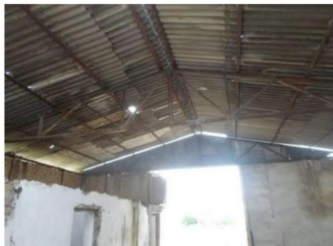
Constructia cu regim de inaltime de parter, are suprafata construita de cca. 320 mp, fundatie din beton, suprastructura din zidarie portanta de caramida, sarpanta metalica cu invelitoare din ondulin azbociment.
