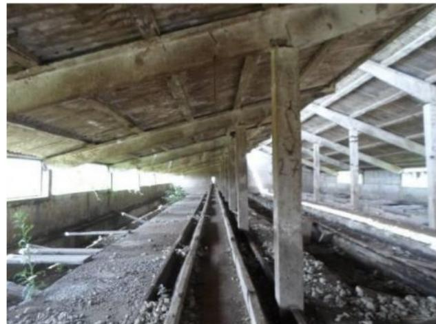
Constructia are regim de inaltime Parter, are o suprafata desfasurata de 1730 mp, avand structura de rezistenta din cadre din beton si caramida portanta, pe fundatie de beton, pereti de compartimentare portanti din caramida, pardoseala realizata din gratare de fier beton armat, acoperis de tip sarpanta cu iluminator cu lumina naturala si invelitoare din placi de azbociment.
