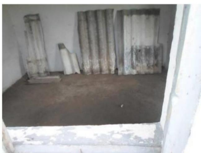
Constructia cu regim de inaltime Parter, are o suprafata construita de cca. 23 mp, fundatie din beton, suprastructura din zidarie portanta de caramida, acoperis cu sarpanta lemn si invelitoare din ondulin azbociment.
