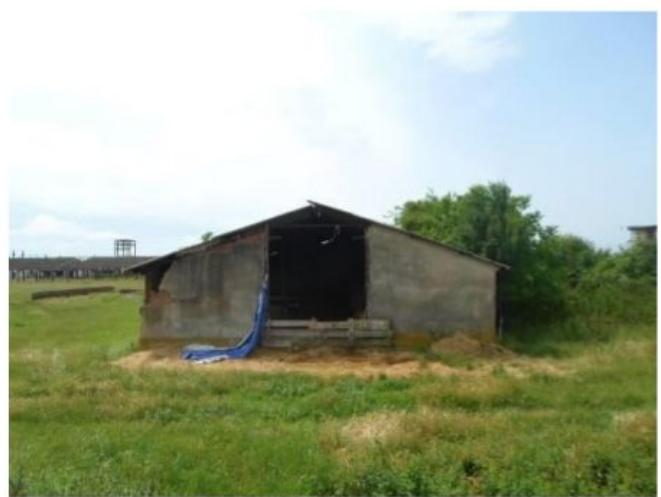
Constructia cu regim de inaltime Parter, are o suprafata construita de cca. 480 mp, avand structura de rezistenta din cadre din beton si caramida portanta, pe fundatie de beton, compartimentare: caramida, sarpanta metalica si invelitoare din ondulin azbociment.
