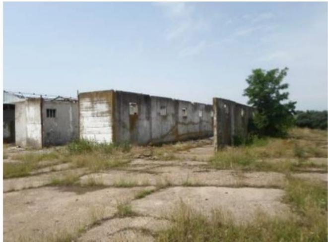
Constructia cu regim de inaltime de parter, are suprafata construita de cca. 320 mp, fundatie din beton, suprastructura din zidarie portanta de caramida, sarpanta metalica.
