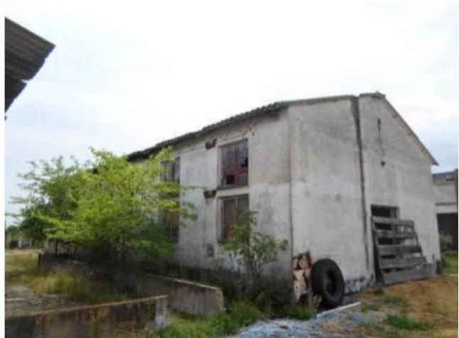
Constructia cu regim de inaltime de parter, are suprafata construita de cca. 180 mp si o suprafata construita desfasurata de cca 360 mp, pe fundatie din beton, suprastructura din zidarie portanta de caramida, planseu din beton armat, acoperis cu sarpanta si invelitoare din ondulin azbociment.
