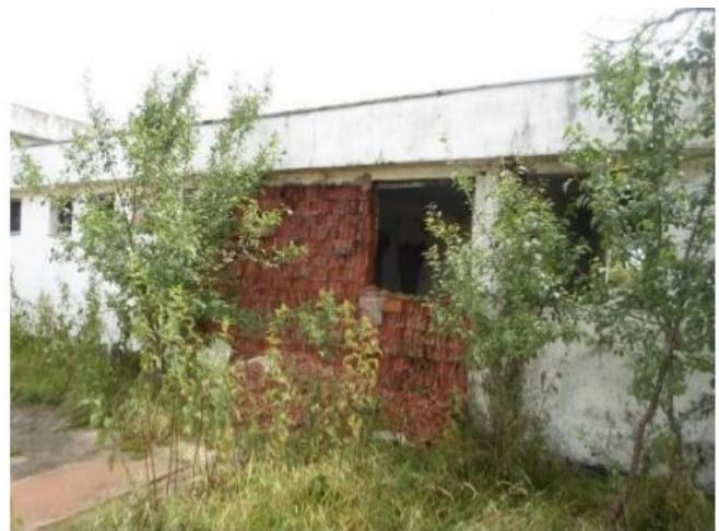
Constructia cu regim de inaltime de parter, are suprafata construita de 207 mp, pe fundatie din beton, suprastructura din zidarie portanta de caramida, acoperis de tip terasa cu invelitoare din membrana bituminoasa.
