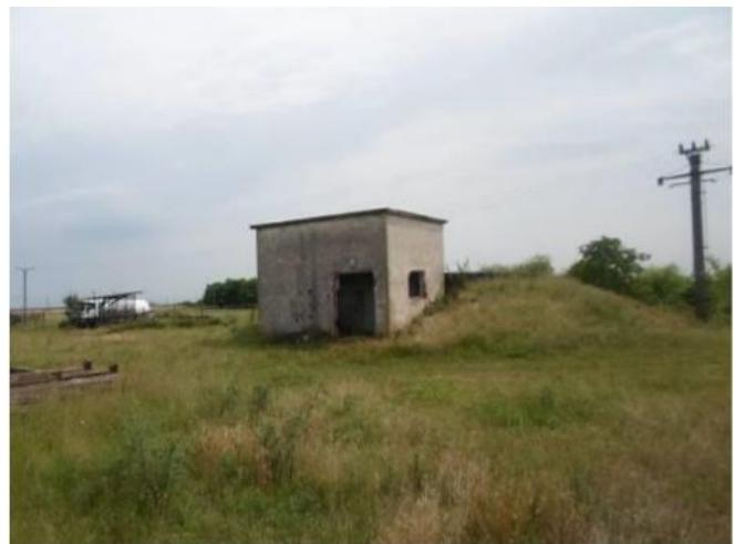
Constructia cu regim de inaltime de parter, dispune de rezervor cu capacitate de cca 200 metri cubi, are fundatie din beton armat, planseul peste peretii rezervorului este din beton armat, acoperis de tip terasa cu invelitoare din membrana bituminoasa.
